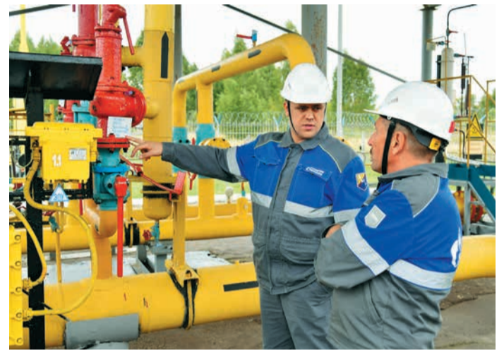
Проверка готовности ГРС
