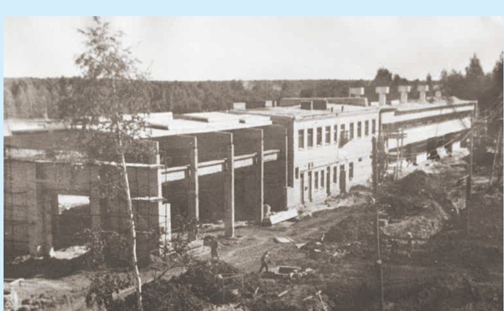
Общий вид строительства компрессорного цеха КС № 6 газопровода «Саратов–Горький», май 1961 года
