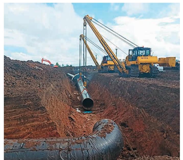
Капитальный ремонт технологических трубопроводов
