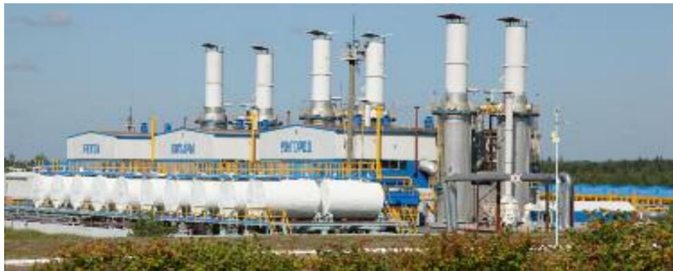
Сегодня Волжское управление обслуживает две компрессорные станции: ГКС-5 «Помары» и КС-22 «Помарская», в состав которых входит 8 компрессорных цехов, оснащенных 49 газоперекачивающими агрегатами, суммарная установленная мощность составляет более 600 МВт. В настоящее время Волжское ЛПУМГ по общей мощности эксплуатируемых газоперекачивающих агрегатов занимает первое место среди филиалов нашего Общества. Объем транспортируемого Волжским ЛПУМГ газа ежегодно составляет более 179 млрд куб. м.
