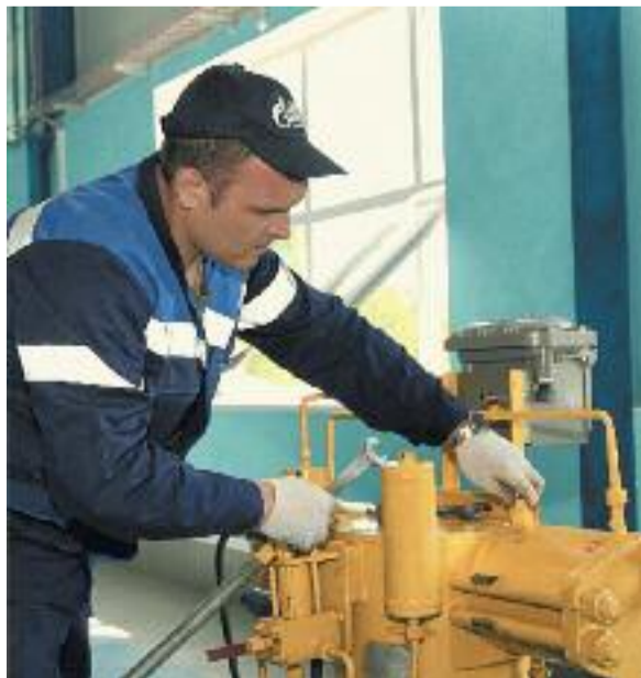
Александр Токарев, оператор ГРС Арзамасского филиала, уверенно выполняет перестановку крана ДУ-300
