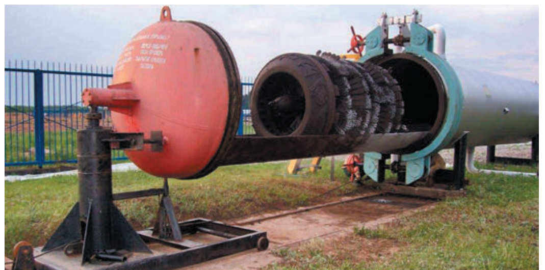
Очистной поршень прибыл, на очереди — второй снаряд
