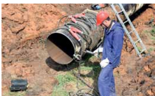
Стабилизация намагниченности трубы вблизи свариваемых кромок газопровода
