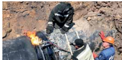
Ремонт магистрали Ямбург — Тула II в Арзамасском ЛПУМГ
