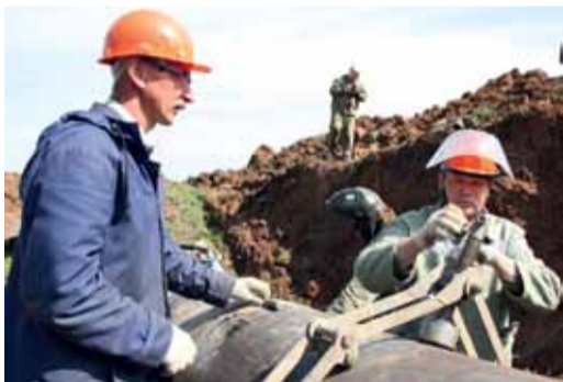
Установка заглушки. Газ потребителям пойдет по временной схеме
