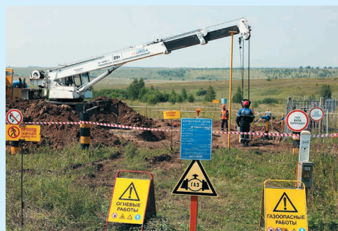
Огневые работы на газопроводе Саратов–Горький, замена дефектного тройника, Арзамасское ЛПУМГ, 2018 год
