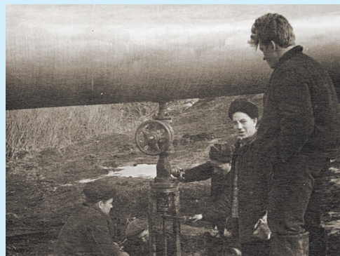
Огневые работы на газопроводе Саратов–Горький, сверление свечи отвода конденсата, 1961 год
