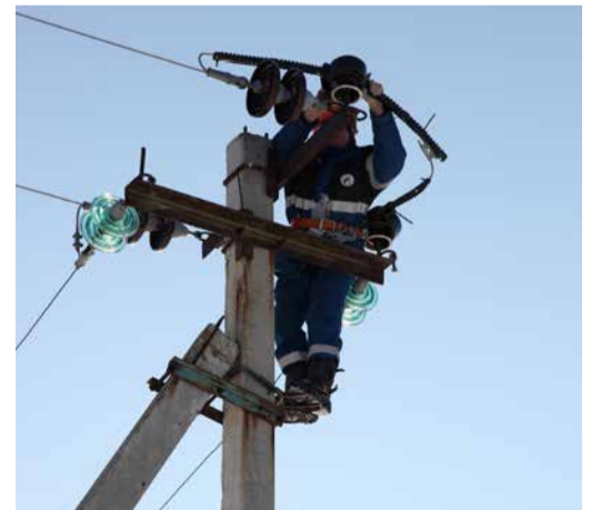
Установка птицевоздушных устройств
