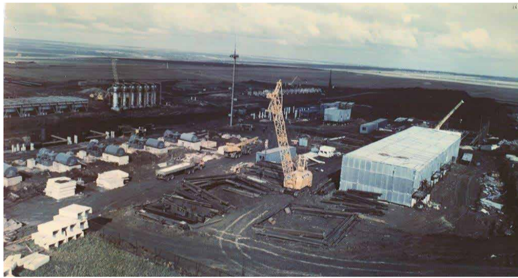
Строительство КС «Сеченовская», 1983 г.
